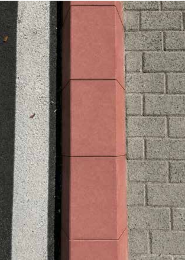
detalle BORDILLO BORDE DE LÍMITE 30x25x30x18
