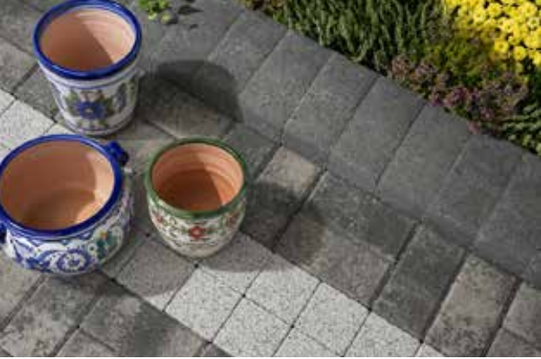
detalle BORDILLO 12X25X16 colocado tumbado
