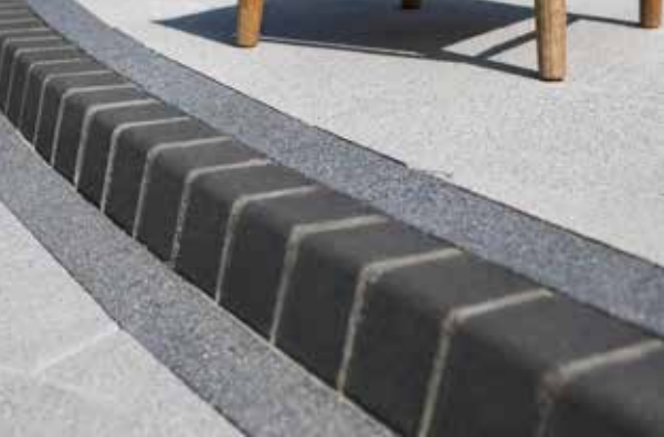
detalle BORDILLO 12X25X16 colocado de pie
