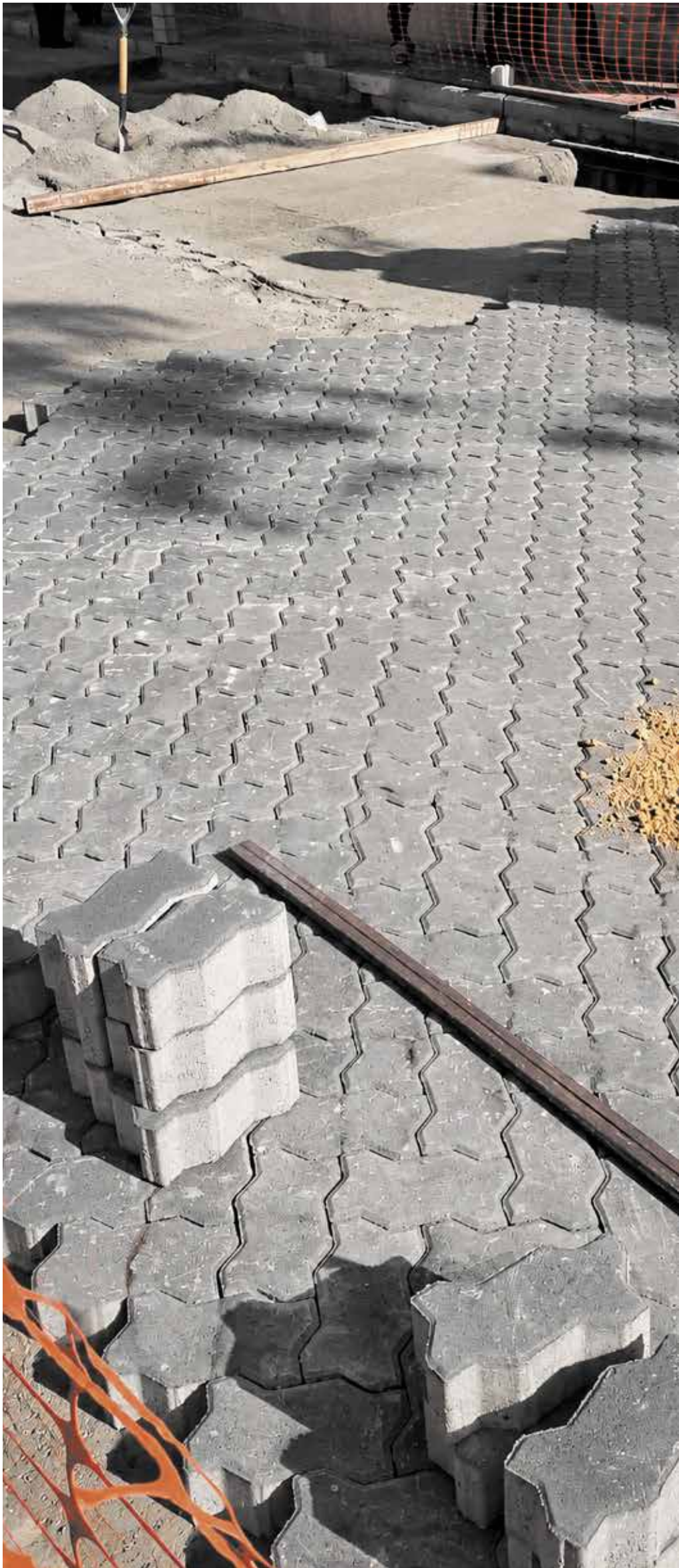
TRANSMISIÓN DE ESFUERZOS SOBRE ADOQUÍN 20X10X8 TRANSMISSION OF FORCES ON PAVING STONES 20X10X8
